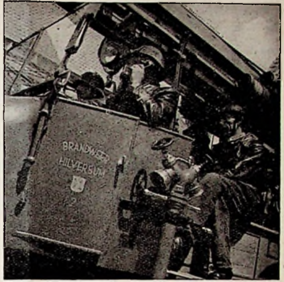
Fig. 2. De brandweer te Hilversum maakt gebruik van een mobiele radio-telefoon-
